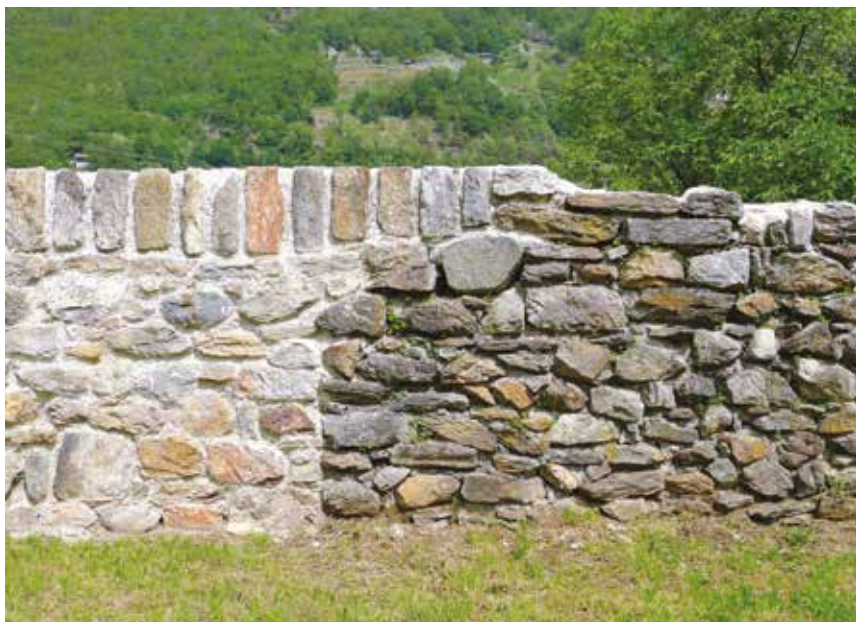
Fig. 234 Consolidamento delle murature originarie e integrazioni moderne.
