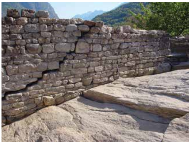
Fig. 91 Edificio sud J. Muro M8 con crepa diagonale causata probabilmente dalla distruzione del 1402. Veduta verso sud (2003).
