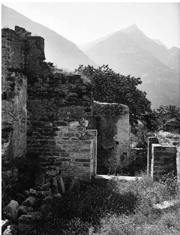
Fig. 17 Vista da nord del portone D. In questo scatto del 1935 sono ben riconoscibili le parti ricostruite (malta di colore chiaro); il portone interno, in primo piano, mostra gli stipiti ricostruiti.
