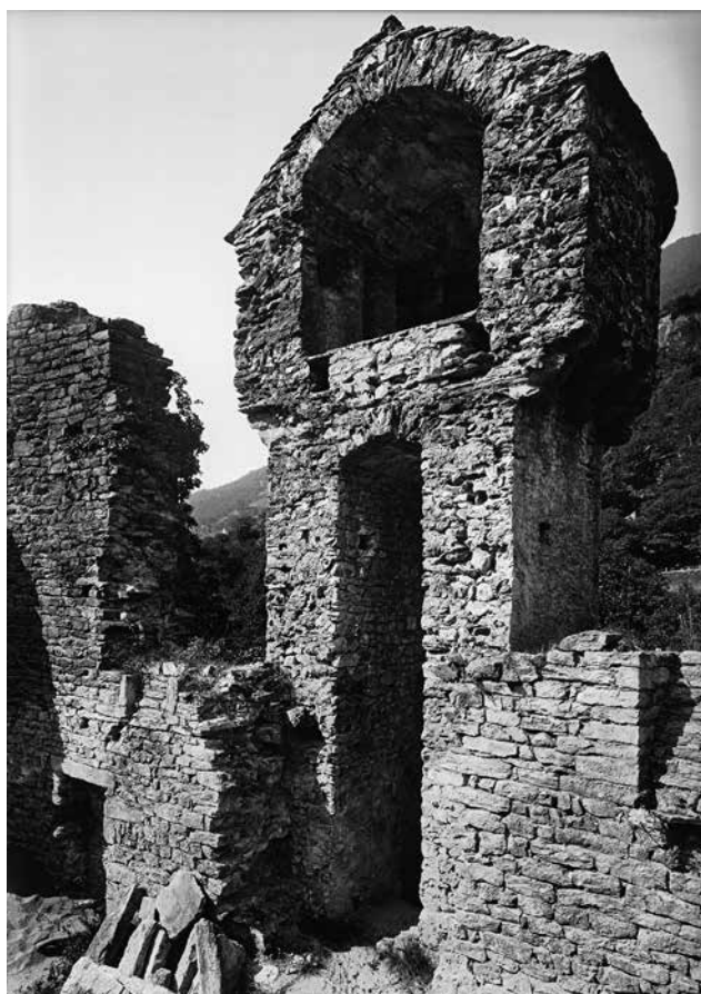
Fig. 18 Torre del pozzo U, vista da est. Le parti in malta chiara mettono in evidenza la parti murarie ricostruite nel 1930-1932. La parte superiore in aggetto sembra essere stata risparmiata da tali interventi. L'immagine mostra chiaramente come la torre U fosse collegata esternamente al muro di cinta preesistente.
