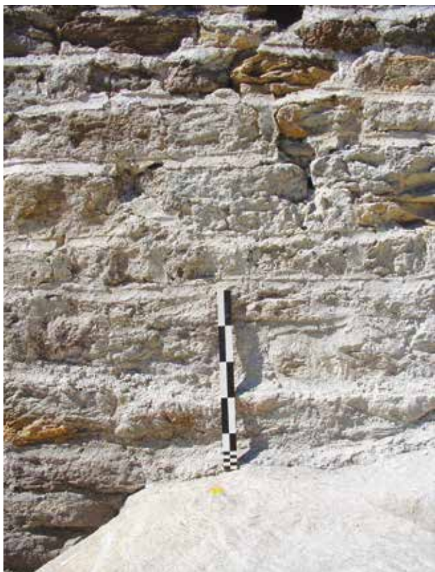
Fig. 32 Area A 24. Paramento esterno del muro del palatium M2b, con intonacatura a rasa pietra con fughe finte tracciate a cazzuola (2005).
