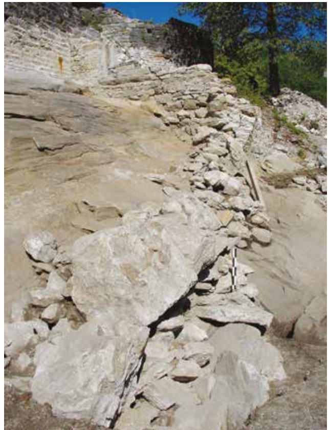
Fig. 98 Accesso fortificato X. In primo piano il muro M14b, scivolato verso valle e frantumato; in secondo piano il muro M14c con il portale d'accesso. Veduta verso nord-ovest (2005).
