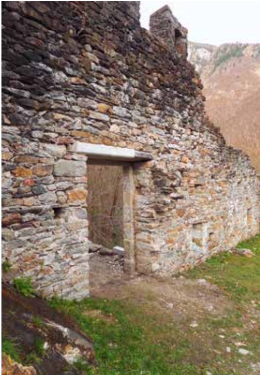
Fig. 235 Integrazione di un'architrave.
