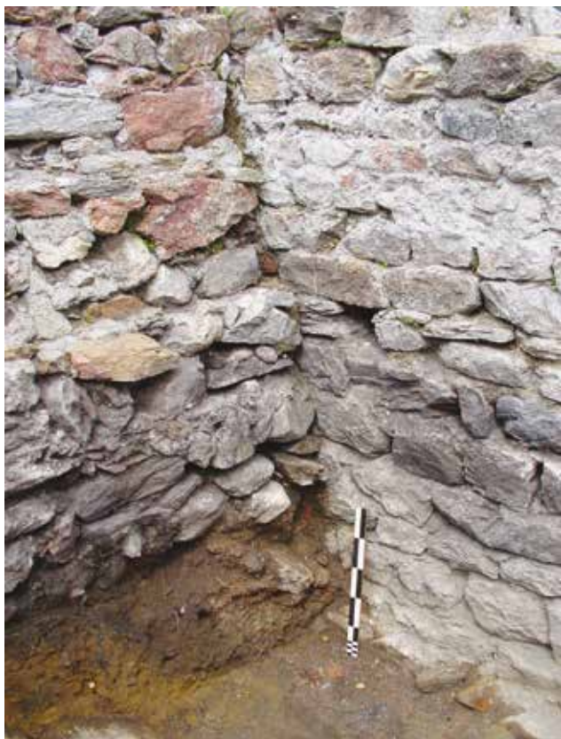
Fig. 71 Cortile interno, locale C, area A 59. Congiunzione del muro di cinta M9 (a destra, fase II/1) e del muro di suddivisione più recente M12a (a sinistra). Veduta verso nord (2006).
