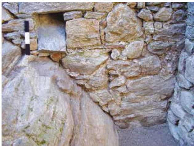
Fig. 68 Edificio delle latrine L, area A 23. Apertura del canale di scarico (muro M4a) in uso prima della costruzione delle latrine. Veduta verso sud-est (2004).
