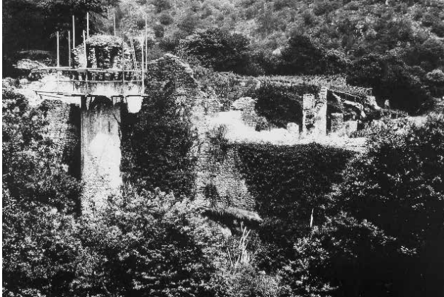
Fig. 22 Interventi di restauro alla torre del pozzo U nel 1929. Da notare l'impalcatura che riutilizza le buche pontate originali della torre.
