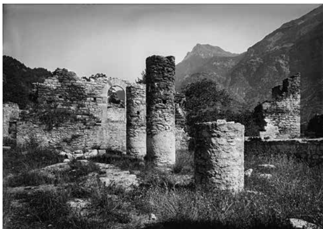
Fig. 15 Cortile interno B con le tre colonne. In secondo piano il palatium con il portale ad arco ricostruito. Foto del 1935, realizzata due anni dopo i lavori di sgombero e gli interventi di consolidamento. Le superfici chiare di malta fresca sulla muratura mostrano chiaramente le parti ricostruite; ad es. il pilastro a sud del cortile interno è ricostruito; su entrambe le planimetrie (vedi fig. 6) sono raffigurati solo due pilastri.
