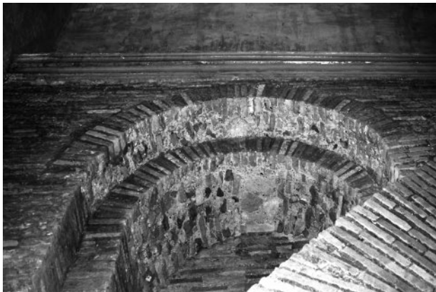
186. Rom, S. Gregorio Nazianzeno. Mauerwerk der abgetreppten Nischenarkaden an der Nordwand Phase II. (Foto Senekovic 2003)
