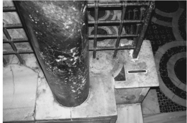
402. Rom, S. Lorenzo fuori le mura, Krypta, Auflage der Säule auf die Deckplatte der Ost-Confessio (Foto Mondini 2005)
