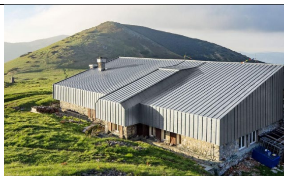
Fig. 4 : toiture en alliage Zn-Ti © rheinzink.ch
