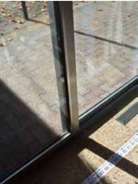
> Figura II.1.1. I serramenti vetrati scorrevoli del primo blocco aule allo stato attuale: i vetri singoli originari sono stati sostituiti con doppi vetri (foto Accademia di architettura-USI, studenti: Marco Brighenti, Emanuele Carcano, Costanza Giordano).
