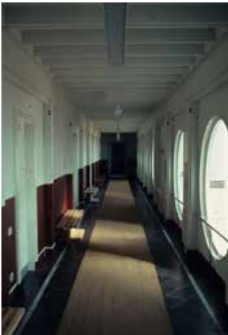
> Figure 9 e 10. Corridoio e scale delle maniche con gli uffici, caratterizzate da una fascia inferiore dipinta di colore rosso scuro e rivestimenti in marmo e piastrelle di asfalto precompresso (ASV).
