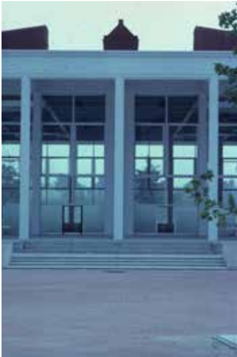
> Figure VIII.3.1-2 Cornicione dell'edificio pubblico prima e dopo l'aggiunta della scossalina pe- rimetrale, avvenuta negli anni Novanta (ASV; foto Accademia di architettu- ra-USI, studenti: Simon Bohnet, Luca Borlenghi, Daria Moatazed-Keivani, Moritz Schnettler).
