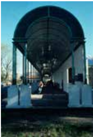
> Figure III.1.2-3. Il porticato a nord del secondo blocco aule prima e dopo l'intervento di risanamento (1993-1994): tutte le strutture metalliche sono state sostituite, ad eccezione dei pilastri che sono stati smontati, puliti, zincati e riverniciati (foto ASV, ca 1978; foto Accademia di architettura-USI, studenti: Luke Peppard, Jurij von Aster, Moritz B. Büchsel).
