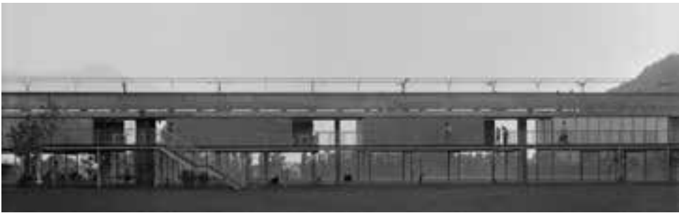
> Figura 9. Aurelio Galfetti, Flora Ruchat e Ivo Trümpy, Bagno pubblico, Bellinzona, 1967-71. Sotto alla passerella pedonale in cemento armato è disposta la struttura metallica modulare degli spogliatoi (Balerna, Archivio del Moderno, Fondo Aurelio Galfetti, foto di Pino Brioschi).
