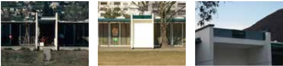
> Figure II.3.8-9. Vista delle coperture in origine (ca 1978) e dopo il risanamento (2017) (foto ASV; foto Roberta Grignolo). > Figura II.3.10. Dettaglio della scossalina metallica dipinta di verde messa in opera per contenere il nuovo "pacchetto" di copertura (foto Roberta Grignolo).
