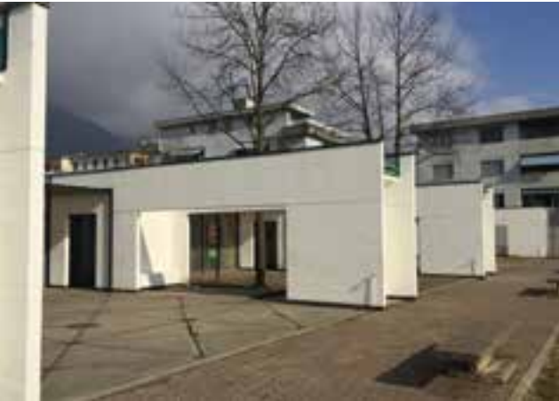
> Figura I.1.2. Negli anni Novanta vengono messe in opera copertine di protezione in lamiera zincata per tutta la lunghezza delle travi (foto Roberta Grignolo, 2017).
