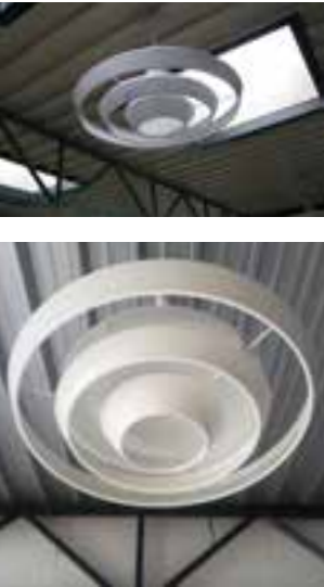
> Figure IV.1.1-2 La lampada Regent d'origine prima e dopo l'inserimento di fonti LED (foto: AUBC; Roberta Grignolo).
