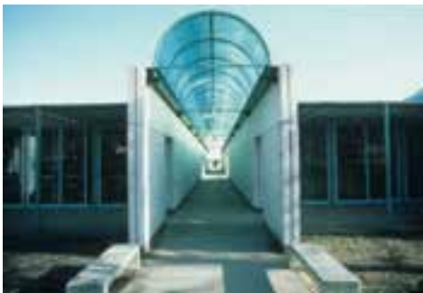
> Figure III.1.7-8. I passaggi voltati intermedi del secondo blocco aule prima e dopo il risanamento (1993-1994): le lastre di tamponamento in materiale traslucido chiaro sono state sostituite con nuove lastre color blu scuro, suggerite da Vacchini stesso. Sono visibili anche le scossaline metalliche aggiunte negli anni Novanta sopra alle travi in calcestruzzo.
