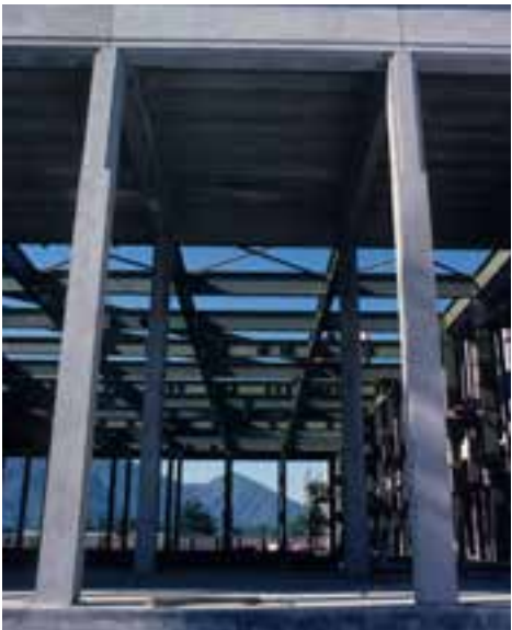
> Figura 4. L'edificio collettivo in cantiere: in primo piano la struttura prefabbricata in calcestruzzo armato, in secondo piano, al centro dell'edificio, la palestra a struttura metallica (ASV). > Figura 5. L'edificio finito, con la struttura in calcestruzzo prefabbricato dipinto di bianco (ASV).
