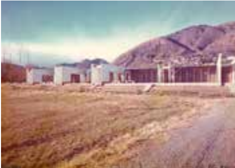
> Figura 19. Scuola elementare ai Saleggi. Variazioni sulla griglia, prospetto ovest, novembre 1974 (Locarno, IM Maggia Engineering SA). In alcuni punti i muri in blocchi di beton delle fasce-servizi proseguono oltre la griglia, prolungandosi fino al confine ovest del lotto.
