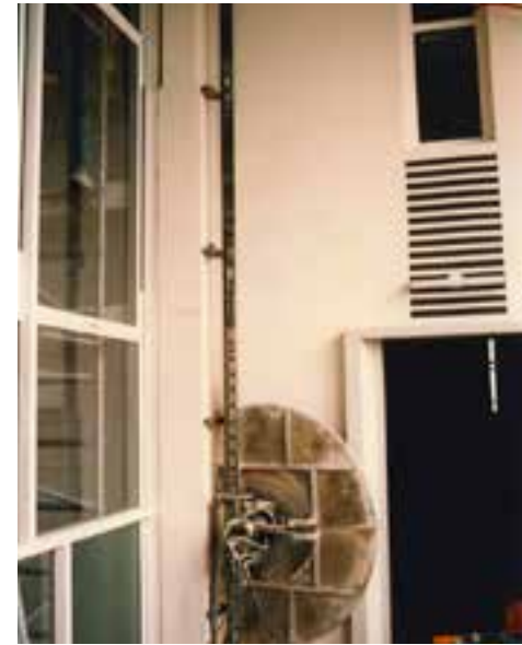
> Figure IX.1-2. Realizzazione del taglio per separare struttura portante e tamponamenti, 1986 (AIMME).
