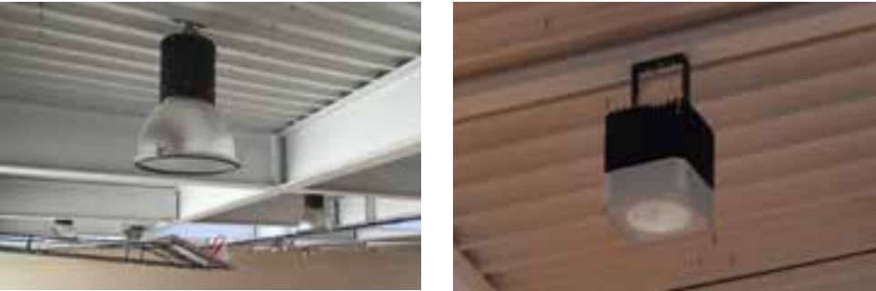
> Figura XIII.1.4. Nuovo corpo illuminante, prodotto da Tulux. Per la messa in opera è stato necessario inserire nuovi profili metallici sotto la lamiera grecata della copertura (foto Accademia di architettura-USI, studenti: Simon Bohnet, Luca Borlenghi, Daria Moatazed-Keivani, Moritz Schnettler).
