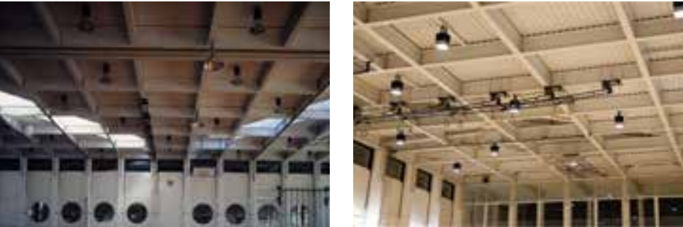
> Figure XIII.1-2. Viste interne della copertura della palestra, con i riflettori d'origine, quelli aggiunti all'inizio degli anni Ottanta e i nuovi corpi illuminanti (ASV; foto Marco Garbani e Gabriele De Lorenzi). > Figura XIII.1.3. Riflettore d'origine della palestra, prodotto da Zumtobel (foto Roberta Grignolo, 2017).
