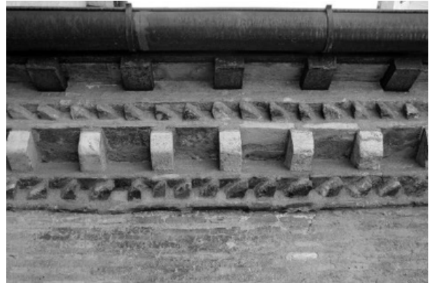
Abb. 21: Rom, S. Marcello al Corso, Sägezahnfries am hochmittelalterlichen Querhaus (Ostwand des Nordflügels), vom Dach des heutigen Seitenschiffes gesehen (Foto Senekovic 2004)
