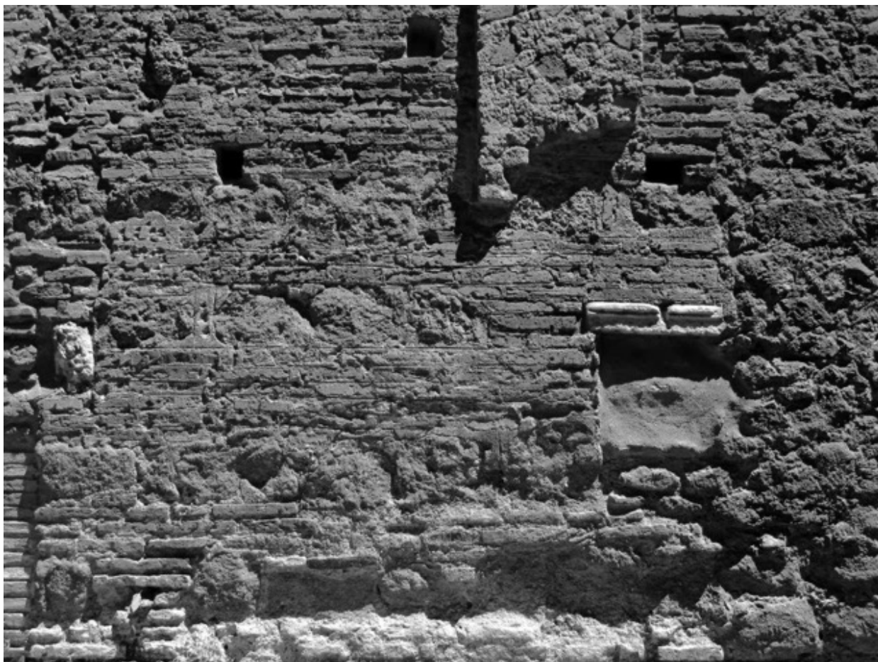
fig. 352: Roma, S. Maria in Tempulo, muratura in opera mista alla base del fianco occidentale del campanile (foto Rossi 2017)
