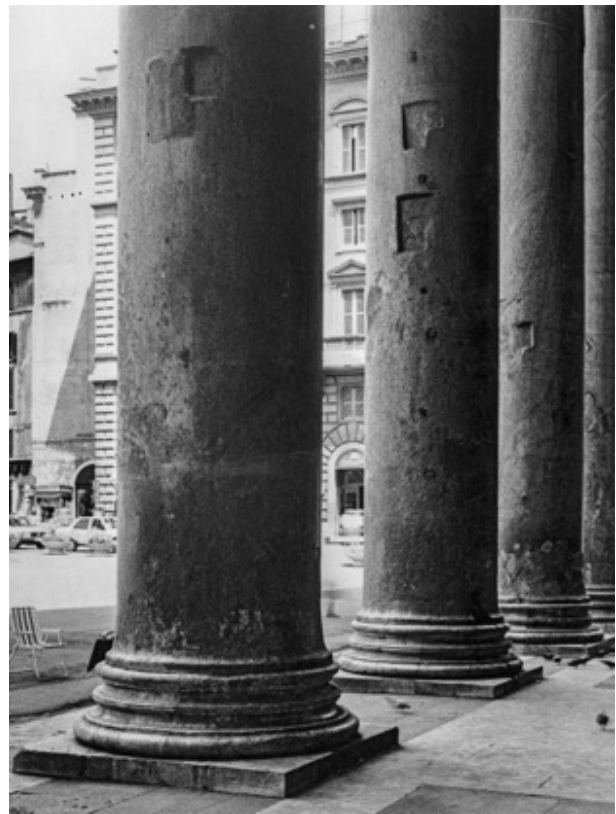
Abb. 327: Pantheon/S. Maria Rotonda, Säulen des Pronaos mit Einlassungsspuren für Scherwände und Portalrahmen (Foto BHR Fotothek)
