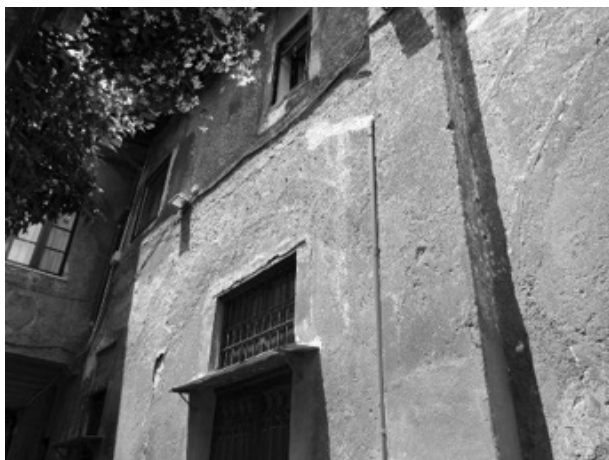
fig. 319: Roma, S. Maria del Priorato, fronte del fabbricato addossato al fianco S/E della chiesa, con due ghiere delle arcate tamponate visibili al di sotto dell'intonaco (foto Pollio 2016)
