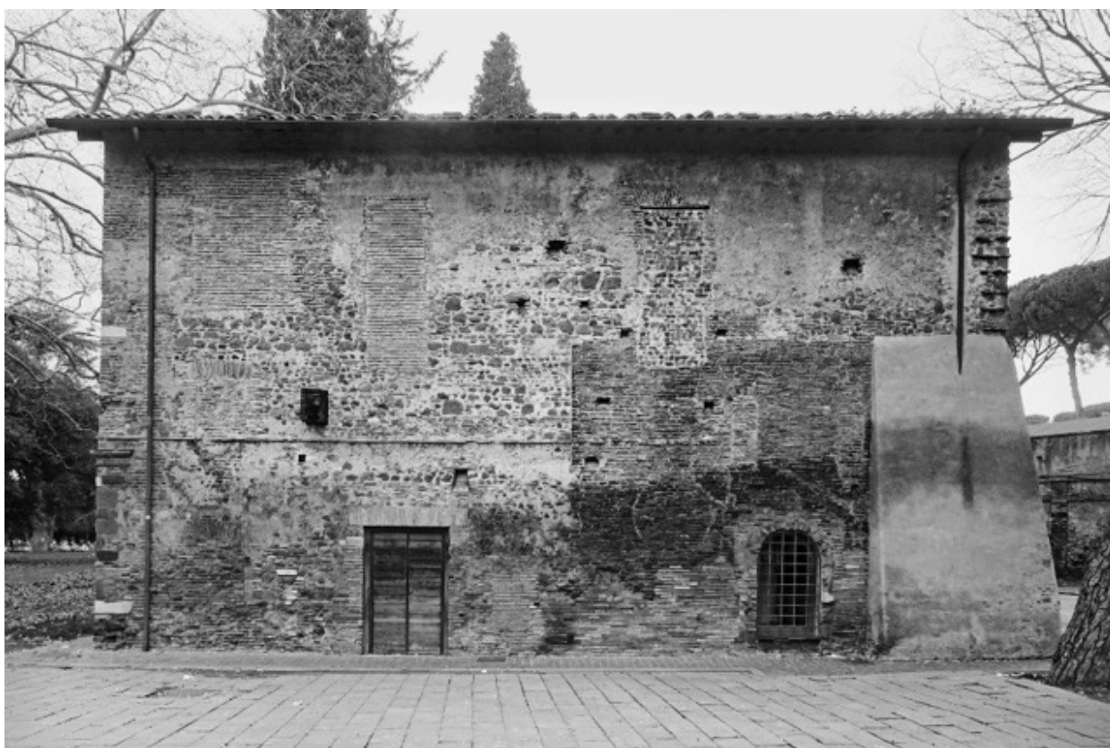
fig. 356: Roma, S. Maria in Tempulo, prospetto meridionale: sulla destra si conserva un tratto della muratura medievale in laterizi, con una coppia di monofore tamponate (foto Senekovic 2017)
