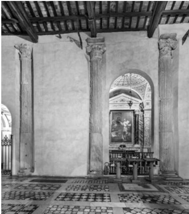
Abb. 111: Rom, S. Maria in Cosmedin, Nördliche Seitenschiffsmauer mit den verbauten Säulen der spätantiken Halle (Foto BHR Fontolan 2017)
