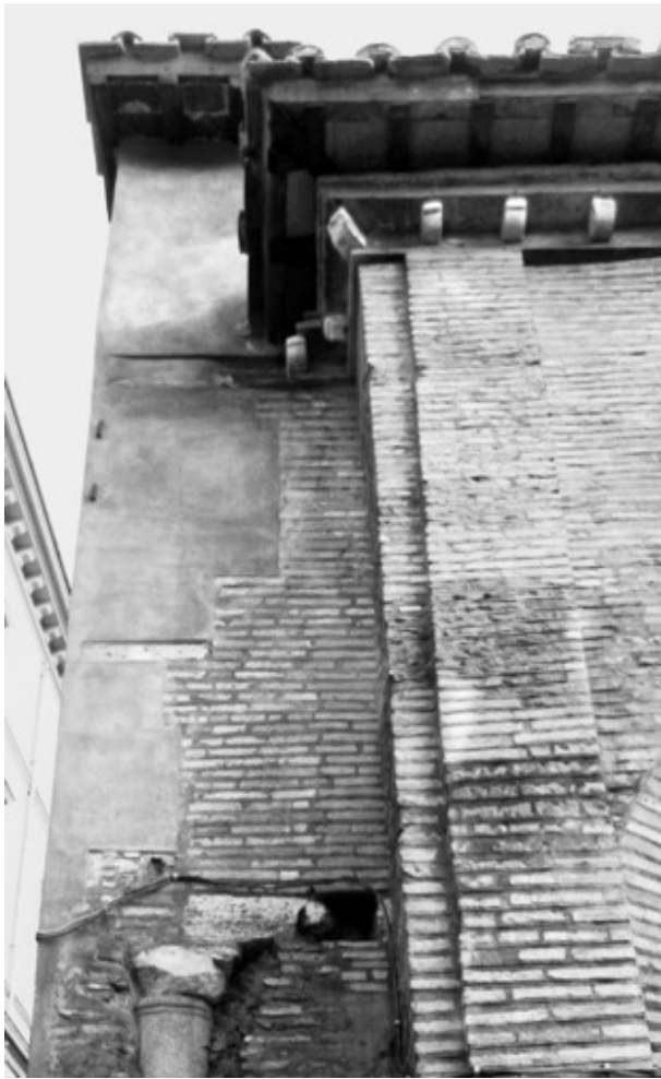
Abb. 141: Rom, S. Maria in Cosmedin, Nordwestecke der Vorhalle mit den Resten einer Säule und eines Kragbalkens als konstruktive Teile der mittlerweile überbauten ehemaligen nördlichen Vorhallenöffnung (Foto Schmitz 2016)
