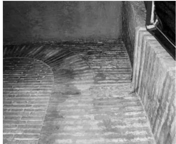
Abb. 128: Rom, S. Maria in Cosmedin, Nordwestecke im Inneren des Turmerdgeschosses mit teils abgearbeitetem und teilweise erhaltenem Gesims (Foto Claussen 2016)
