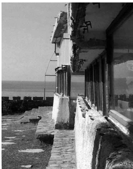
Veduta del prospetto est della galleria, stato di degrado nel 2005 e fotomontaggio della veletta ricostruita; veduta del prospetto est della galleria, degrado dell'intonaco e dei supporti delle persiane nel 2005 (da A. Cerroti, La villa Saracena di Luigi Moretti. Un esperimento di restauro del Moderno , “Arkos”, gennaio-marzo 2005, n. 9, pp. 69 e 68).
